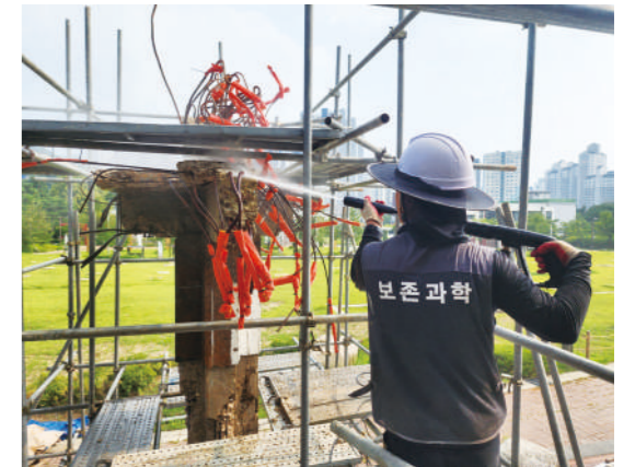
‘어느 건축가의 흔적’ 건축부재 보존처리
