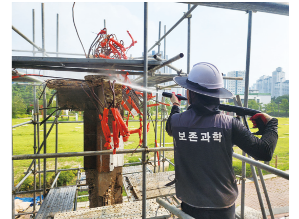
‘어느 건축가의 흔적’ 건축부재 보존처리
